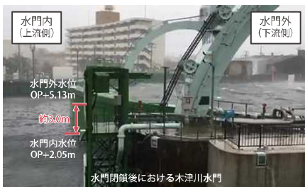
平成30年台風21号襲来時の三大水門閉鎖状況【資料提供：大阪府】
