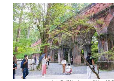
田辺明郎の設計によるレンガ造りの水路橋
