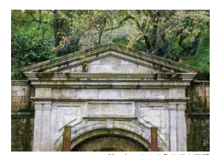
第一トンネルの入り口と竈
