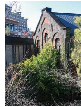
旧 蹴上発電所
